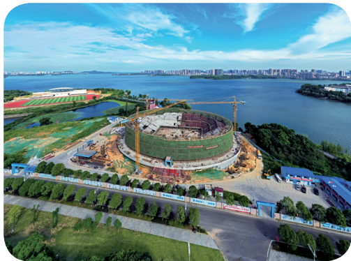
建设中的新体育馆（曾晓剑摄）
